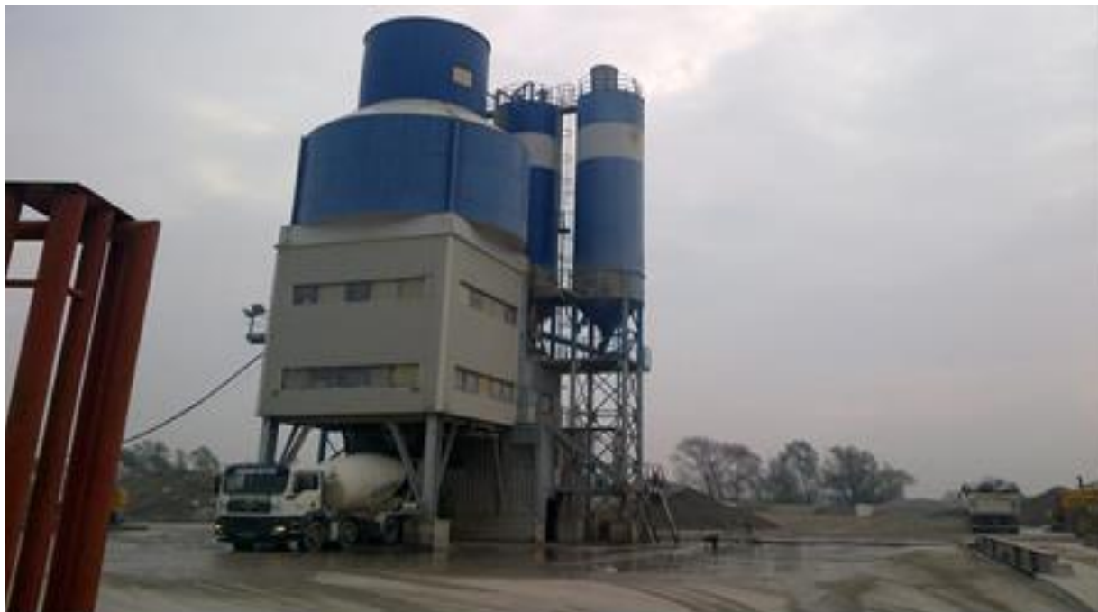
Slika 1. Betonara na na lokaciji Strojarska 5, Sesvetski Kraljevec
