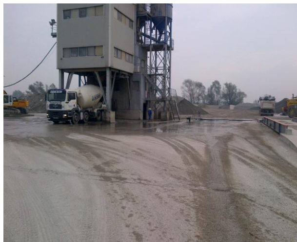
Slika 8. Betonski manipulativni plato betonare sa uređajem za punjenje gotovog proizvoda
