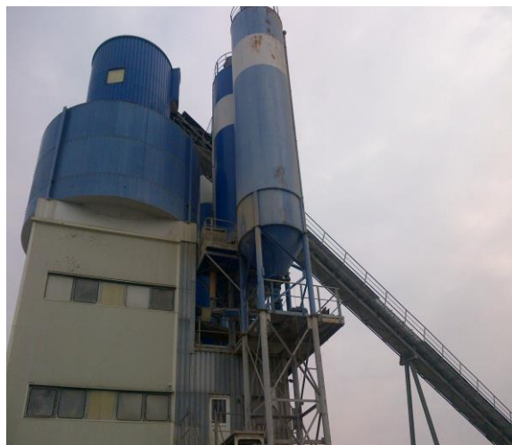
Slika 7. Postrojenje za proizvodnju betona sa pratećim silosima
